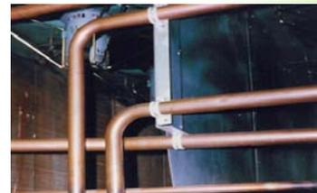
Tubería de cobre revestida con El protector transparente Sea Coast, que la protege contra la corrosión atmosférica en una planta de tratamiento de aguas negras
