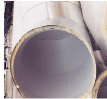
Revestimiento aislante para la protección de los aislantes de fibra contra el deterioro, humedad y hongos. Ayuda a prevenir el "Síndrome del Edificio Enfermo" y el "Síndrome de las Medias Sucias". Previene la penetración de fibra en la corriente de aire. Se usa para ahorrar en la construcción de doble panel cuando se requiere una corriente de aire puro.
